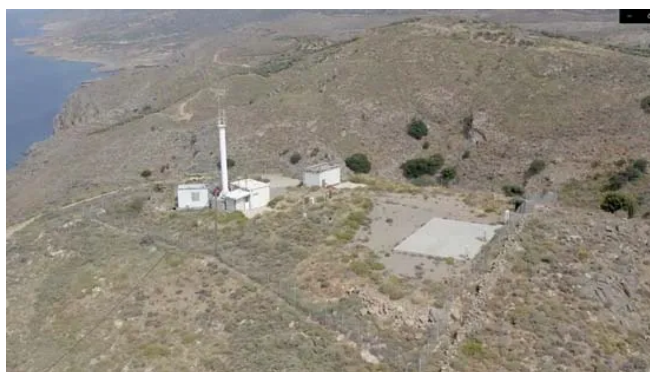
Ο Σταθμός στο Φινοκαλιά μετρά τα επίπεδα των θερμοκηπιακών αερίων από το 2002 με συνεχείς μετρήσεις από το2014 και μετά.
